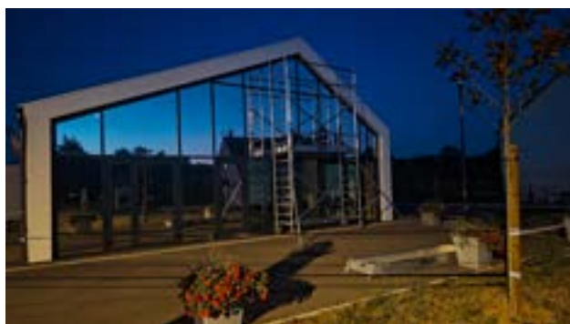
La salle de réunion climatisée et récemment équipée de filtres
